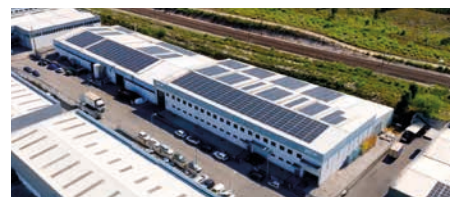
UNIDADE DE OIÃ • Área fabril coberta: +10.000 m 2
